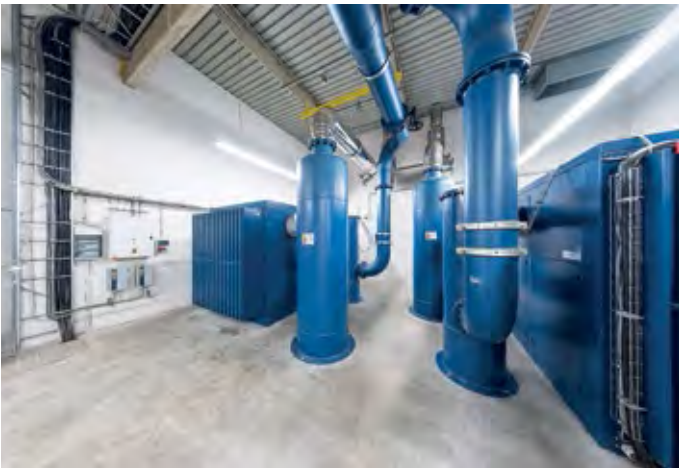
Abb. 2: Schraubenverdichter von Aerzen sorgen bei JTI in Trier für perfekten Unterdruck.
